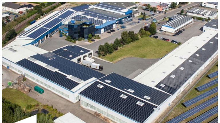
Auf dem Hallendach ist eine Photovoltaik-Anlage installiert, die einen großen Teil des für die Fertigung benötigten Stroms erzeugt.
